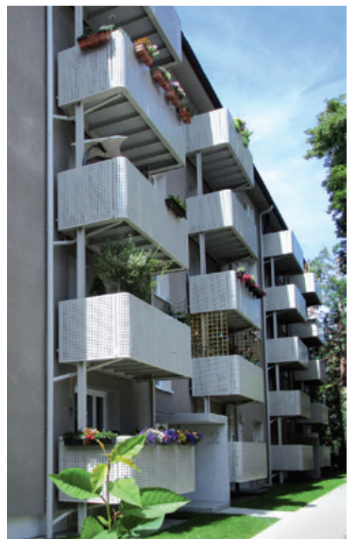
In Freiburg-Haslach hat die BlmA bei neun Mehrfamilienhäusern Balkone angebaut und saniert sowie alle Wohnungen modernisiert.
